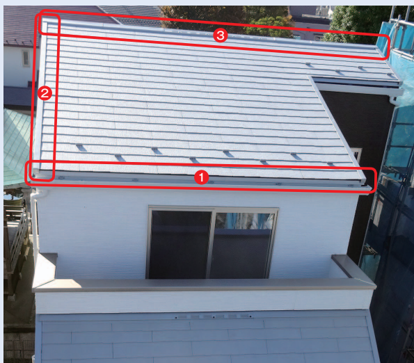
今回は①②③の箇所の施工のポイントを解説する
