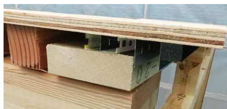
6. 完成 (棟側より見る)
