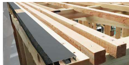
3. 中心付近に取付た調整材
