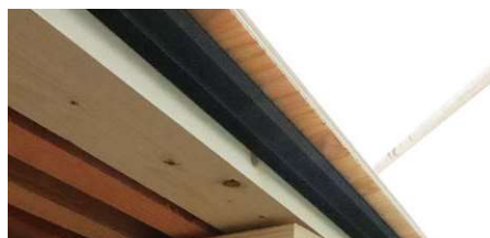
5. 完成 (軒下側より見る)
