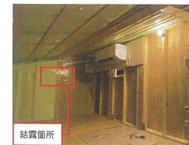
夏的小屋裏の天井面。表面温度が50℃を超えている
