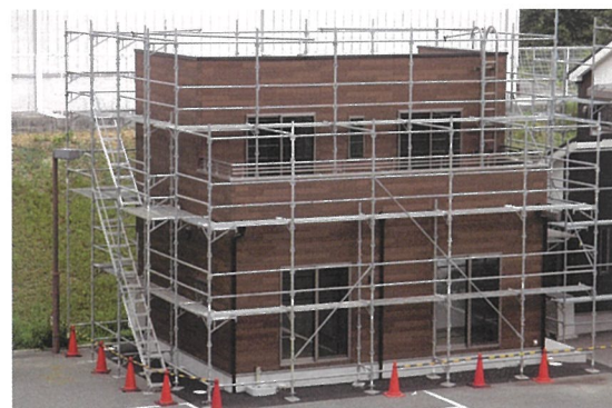
実験棟の外観。小屋裏を4区画に分割。通気層の条件を変えて温湿度を計測
