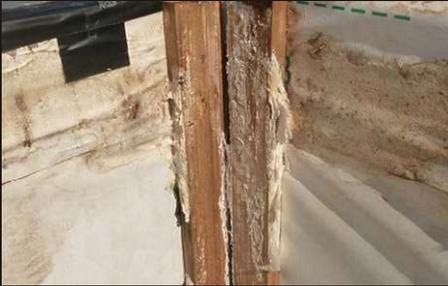
通気層の天端を閉塞することが原因でパラペット壁内部と通気層に熱気が滞留し結露が起こり、胴縁と透湿防水シートに腐朽菌が発生した築1年の住宅の事故事例の写真です。
