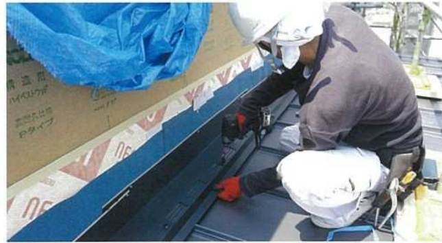
換気孔部分の施工現場(同社提供)
