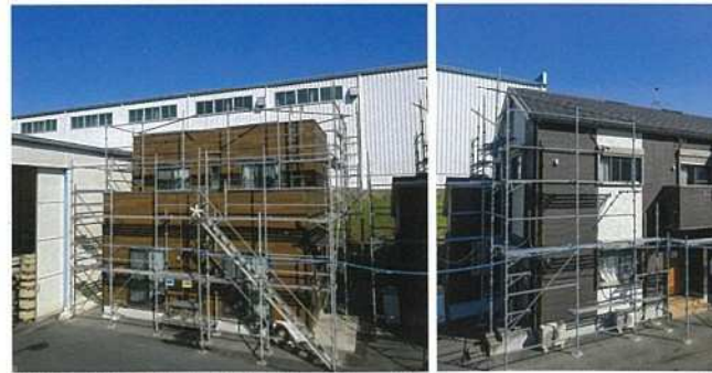
実験棟による実験も行う。屋根の形状・勾配の異なる2棟を準備し異なる条件下で換気システムを設置、通気・換気状況等のデータを観測・収集する。同時に外気の日風速等も測定して影響を確認。これらは研究開発の基礎データとして活用する
