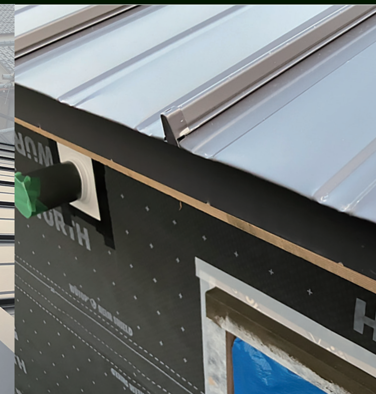
縁創建工房様 通気立平デネブエアルーフご採用の施工現場
