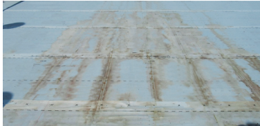
事故写真2 野地合板の腐朽
