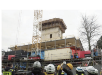
中大規模木造建設現場の視察
