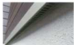
写真1 ねこ土台による床下換気を兼ねた土台水切り
