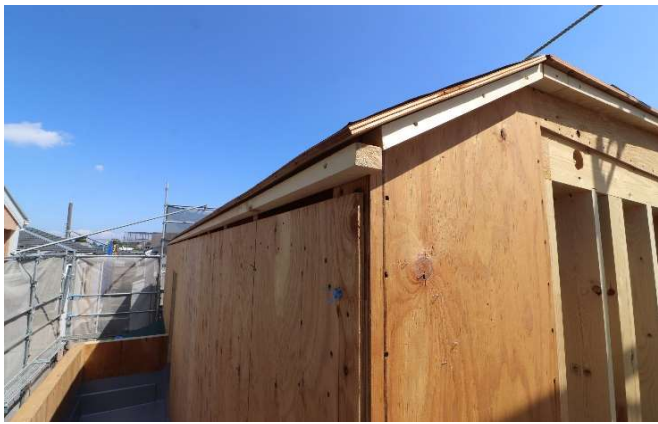
木下地 (30×30) を施工する。
