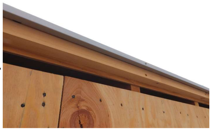
木下地 (30×30) を施工する。
