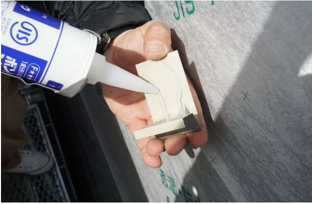
裏面にシーリングを2本入れる。
