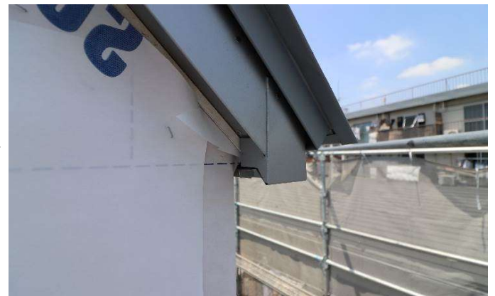
裏面にシーリングを入れ、35mm以上のビス・釘で留めつける。
