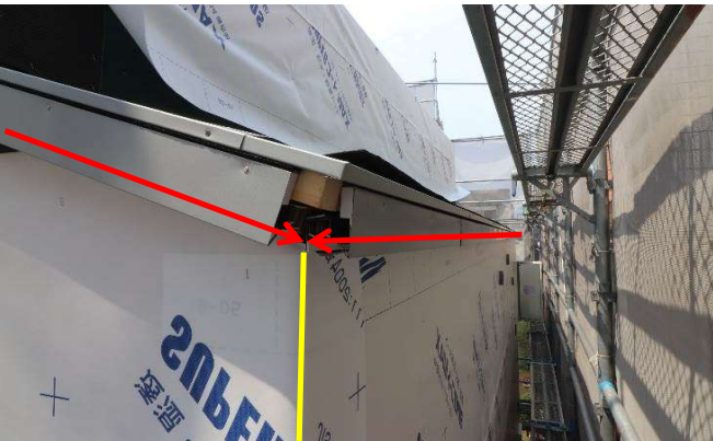
本体を壁面出隅に合わせて施工する。
