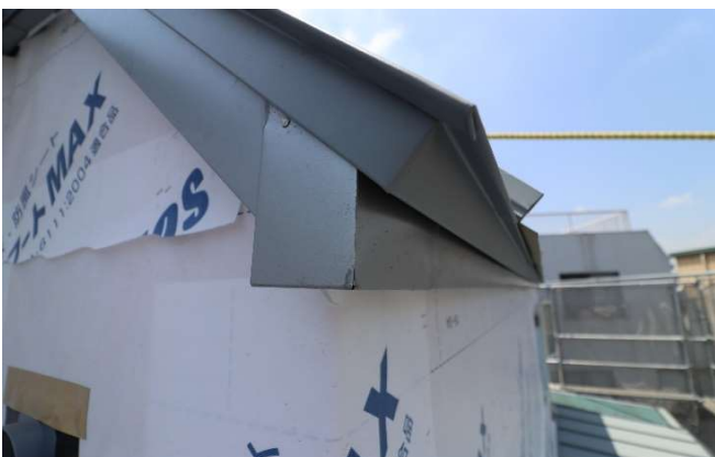
裏面にシーリングを入れ、35mm以上のビス・釘で留めつける。
